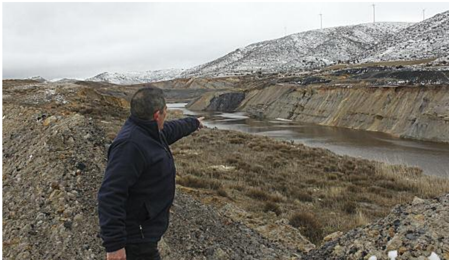
Balsa gigantesca de las antiguas minas Salomé y Carmencita que tienen ácido sulfúrico y que es un peligro por las posibles filtraciones a los manantiales de la zona
