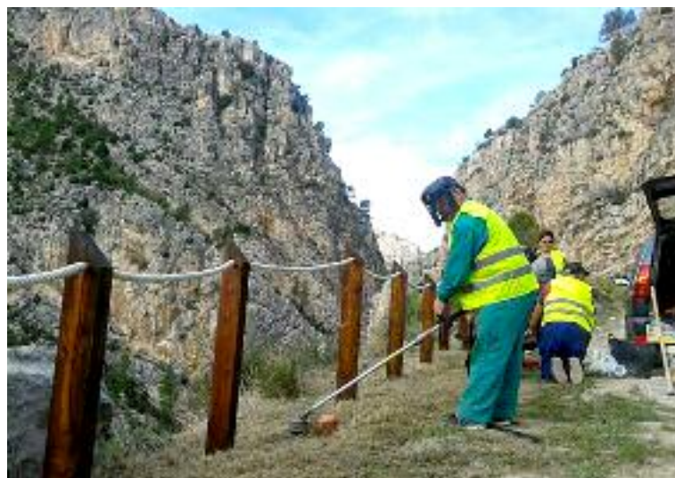
Trabajos realizados por Atadi en el Mirador de Santa Ana, en Tronchón
